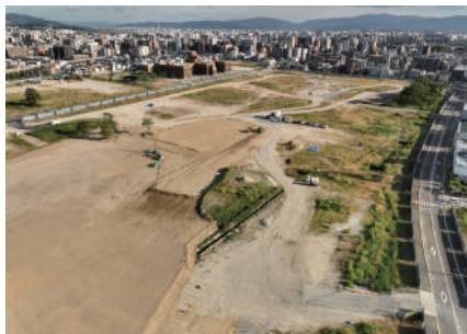
2026年8月6日時点の造成工事の様子
