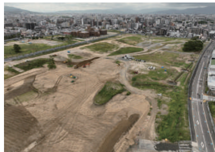
2026年9月6日時点の造成工事の様子
